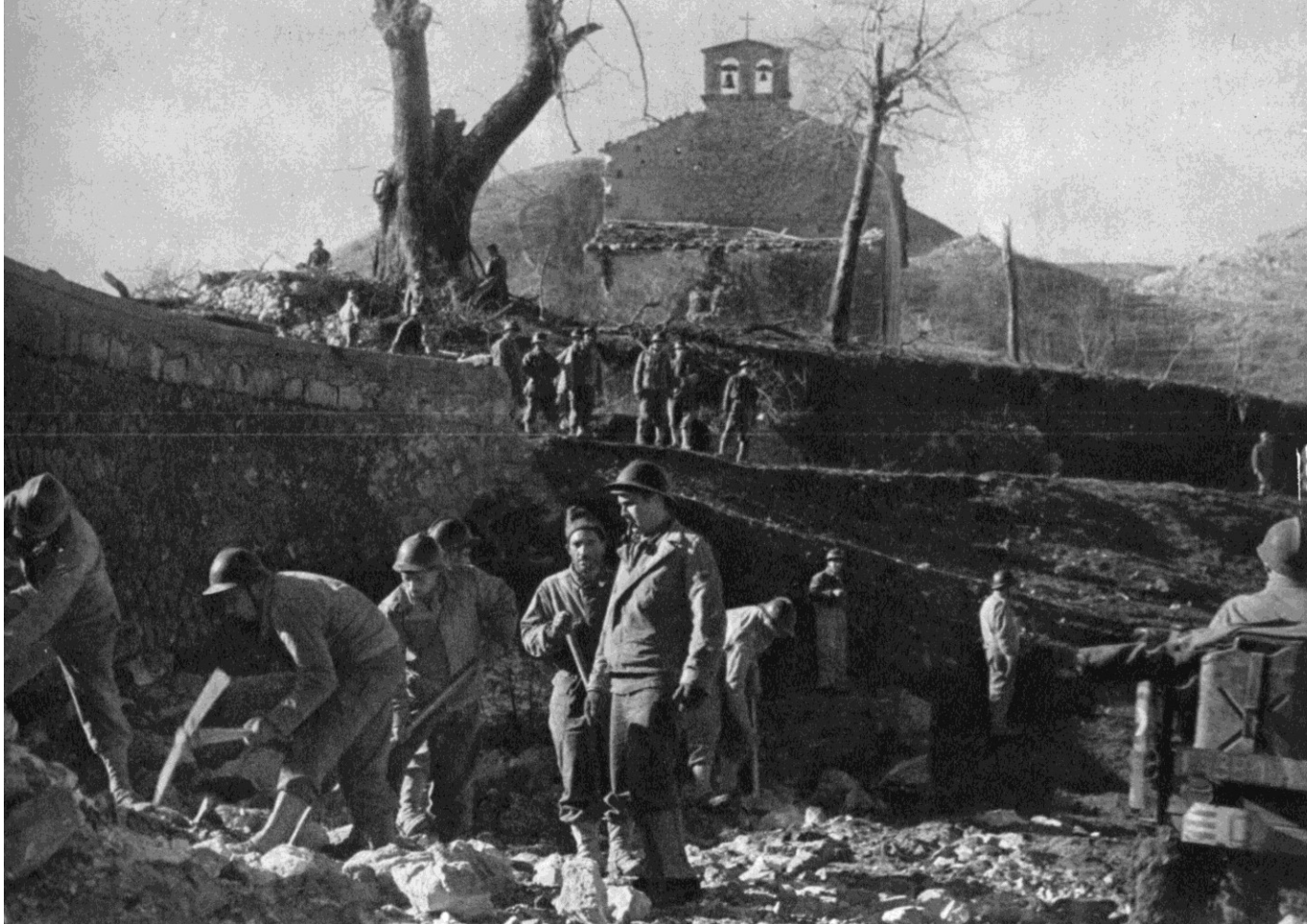
Reconstruction d'une route par nos sapeurs.
