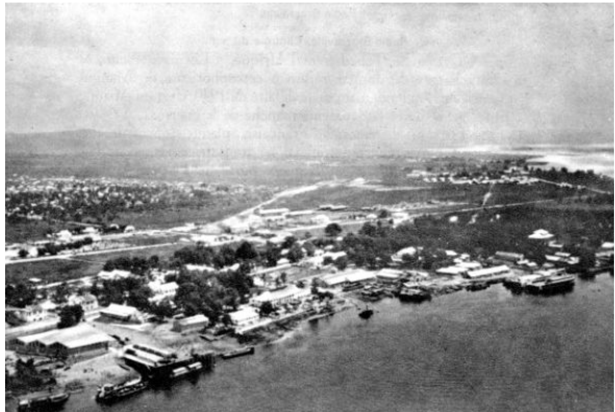
Vue aérienne de Brazzaville et du Port fluvial.
